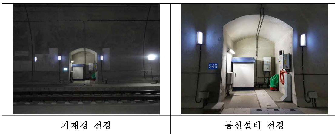
<그림 3.1.28> 부속시설 전경
