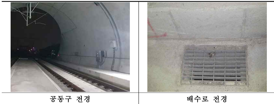
<그림 3.1.24> 공동구 및 배수로 전경
